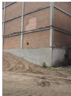
Foto 22. Se pudo levantar una pared al lado de esta estructura
