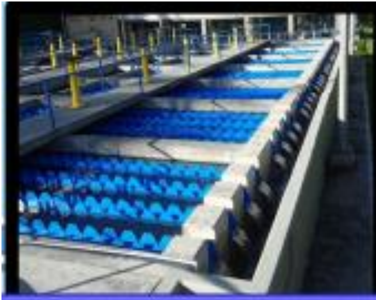
Figura 10. Proceso de Sedimentación
