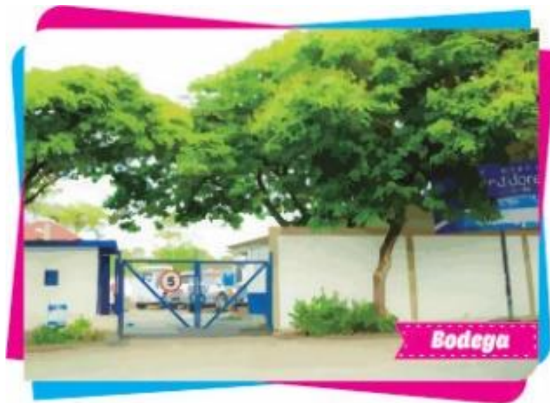
Figura 3. Almacén y bodega carrera 35 No.35-36 Tuluá, Valle del cauca
