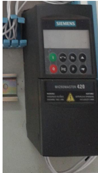
Imagen 27. Variador de velocidad
