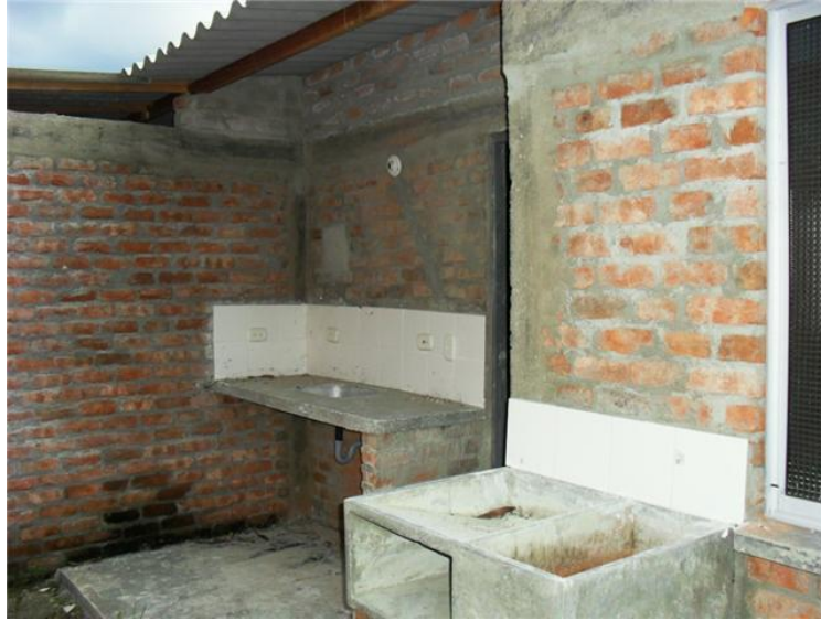
En este estado reciben la casa, deben construir las otras paredes
