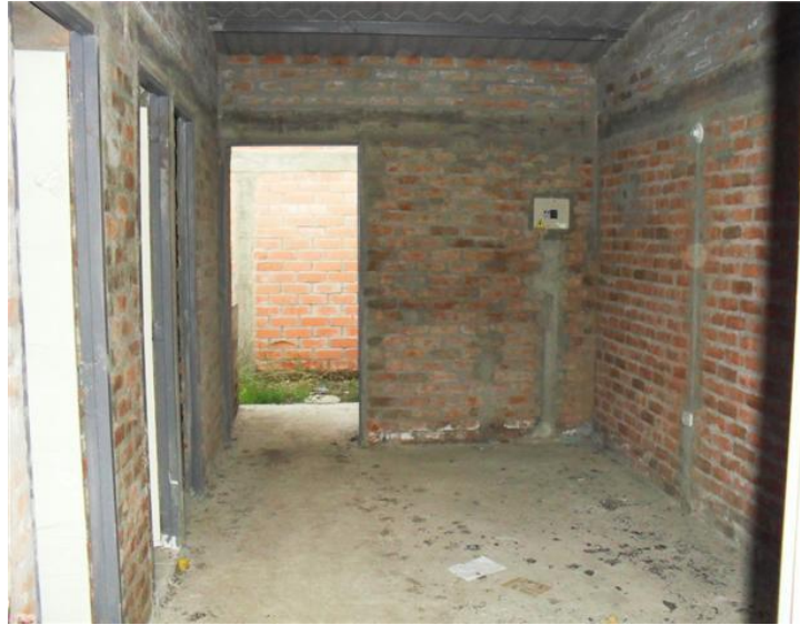
Algunas viviendas están en obra negra y sin acabados
