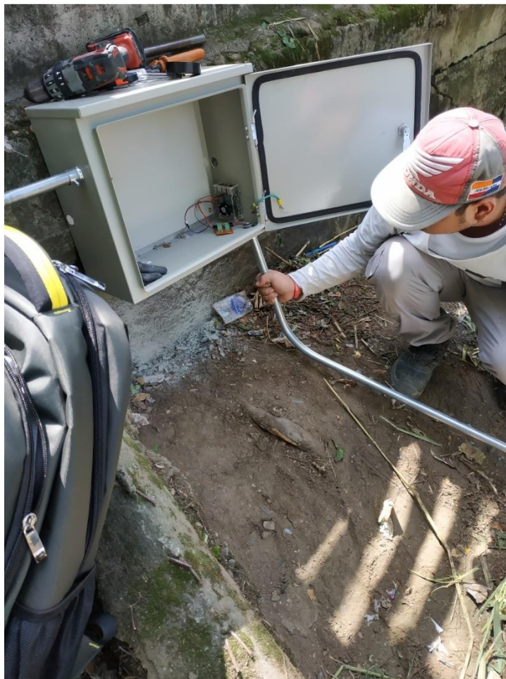
Instalación del Sensor 1 en el Río Morales
