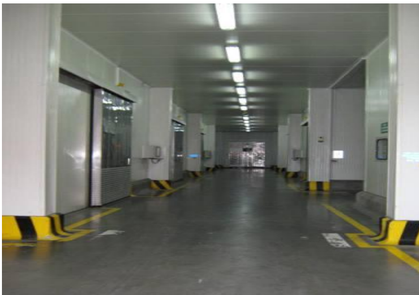
Figura 10. Bodega de Cuartos Fríos Productora de Jugos S.A.S.
