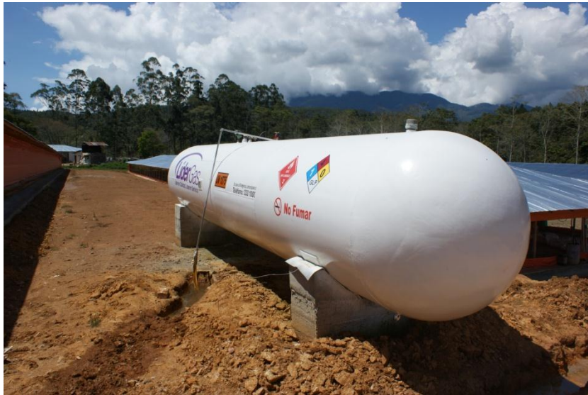
Figura 11. Estación fija de gas.
