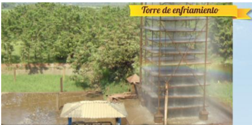
Ilustración 26: Torre de enfriamiento
