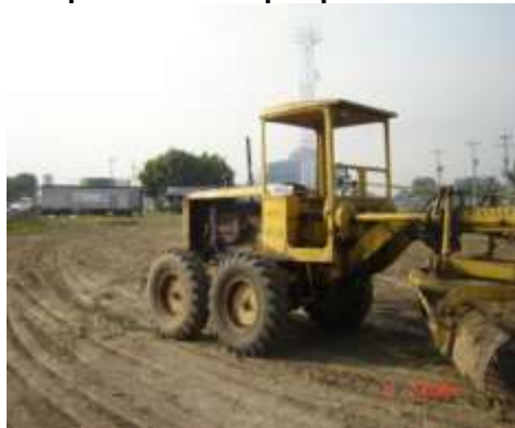
Foto 24. Adecuación del terreno para el nuevo parqueadero de carga
