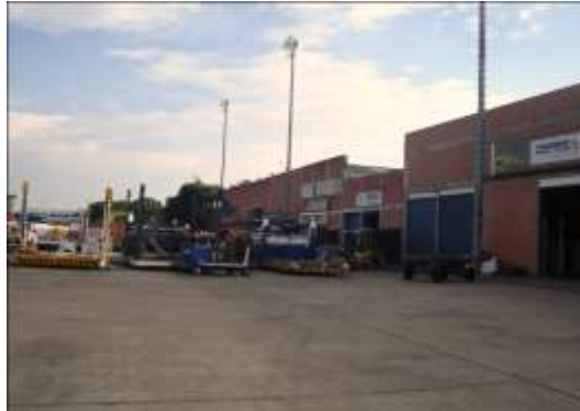
Foto 21. Plataforma de carga interna del aeropuerto
