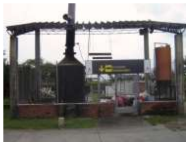
Foto 16. Antiguo incinerador de residuos sólidos aeroportuarios
