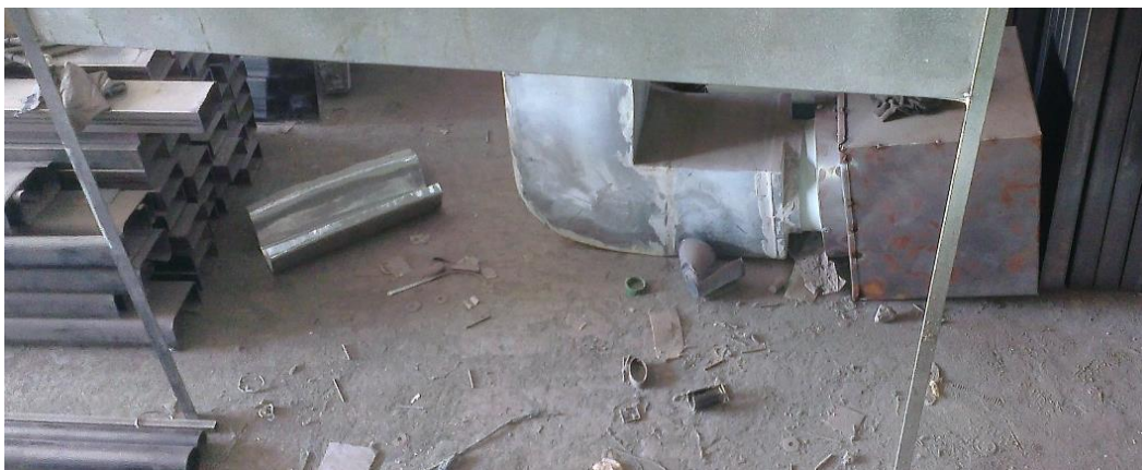
Figura 44. Instalación del sistema de extracción
