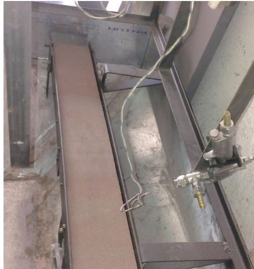
Figura 43.. Instalación de aerógrafos
